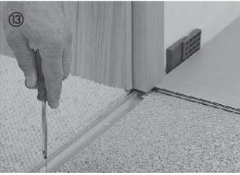
Zur Einhaltung des Dehnungsabstandes muss bei Türübergängen stets ein geeignetes Profilsystem eingesetzt werden. Dies gilt auch, wenn im angrenzenden Raum der gleiche Boden verlegt werden soll. In diesem Fall ist für die Einhaltung der Dehnungsfuge ein Übergangprofil einzusetzen. In der Schiene ist ein Dehnungsabstand von ca. 5 mm einzuhalten. Grundsätzlich müssen Holztürstöcke in Parkettelementdicke mit einer Feinsäge abgeschnitten werden, damit das Parkett eine Dehnungsmöglichkeit hat.
