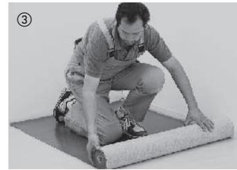
Zur Trittschalldämmung und zum Ausgleich kleiner Unebenheiten wird eine 2 mm dicke Komfort-Dämmunterlage bündig ausgerollt. Geeignete Dämmunterlagen finden Sie in unserem Zubehörangebot. Bitumpappe eignet sich nicht zur Trittschalldämmung. **Parkettboden mit aufkaschierter Dämmunterlage ist für eine vollflächige Verklebung nicht geeignet.**
